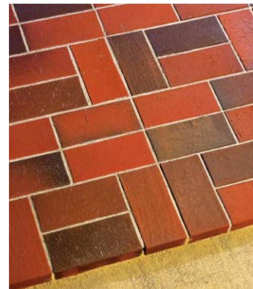
*Blockverband mit Schmuckstreifen aus Pflasterriegeln.*
