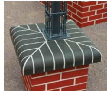
Saubere und präzise Verarbeitung, besonders deutlich sichtbar an den hellen Fugen in den dunklen Pfeiler-abdeckungen.
