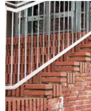
Der erste Entwurf des Architekten sah eine sehr massive, durchgängige Unterkonstruktion aus Stahlbeton vor. Darauf sollten die neuen Stufen gemauert werden. Damit wäre aber das Problem möglicher neuer Frostschäden und Auslaugungen nicht gelöst, weil die Fugen einer konventionell gemauerten Treppe nach wie vor nicht wasserdicht sind.
