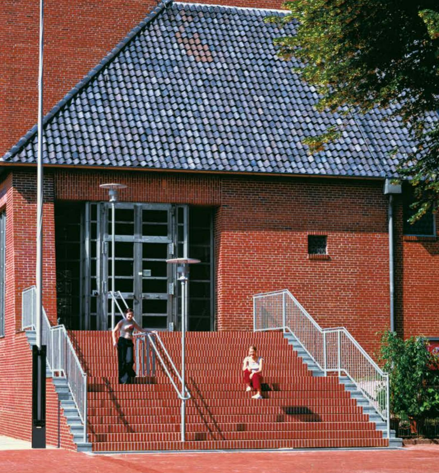
*Technisch besser, wirtschaftlich günstiger und dauerhaft sicherer kann eine Treppenanlage nicht sein. Röben Ziegel-Fertigstufen als 'maßgeschneiderte' Aufgabenlösung.*
