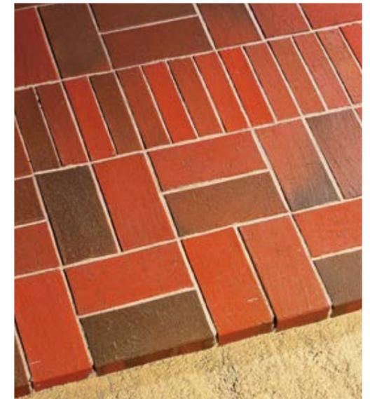
*Abwechselnd je vier Pflasterriegel in gegenläufiger Richtung verlegt.*
